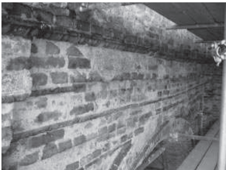
Muratura con cornici e l'arco della volta sinistra del pronao dopo l'intervento.
