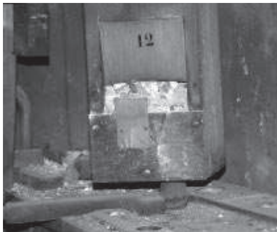
Canna del registro Subbasso 16' prima dei lavori (particolare).
